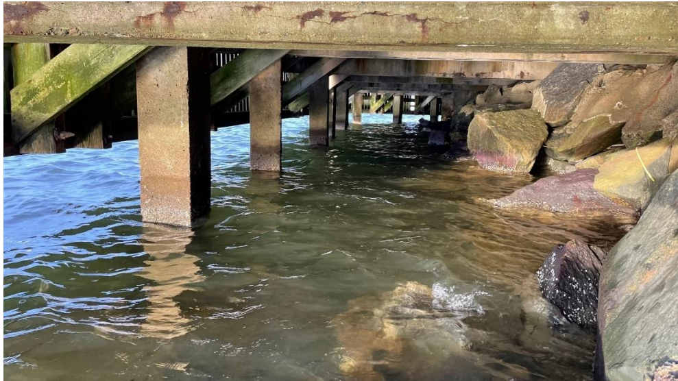
Figur 9 Under befintlig träbrygga (COWI 2022-03-25).
