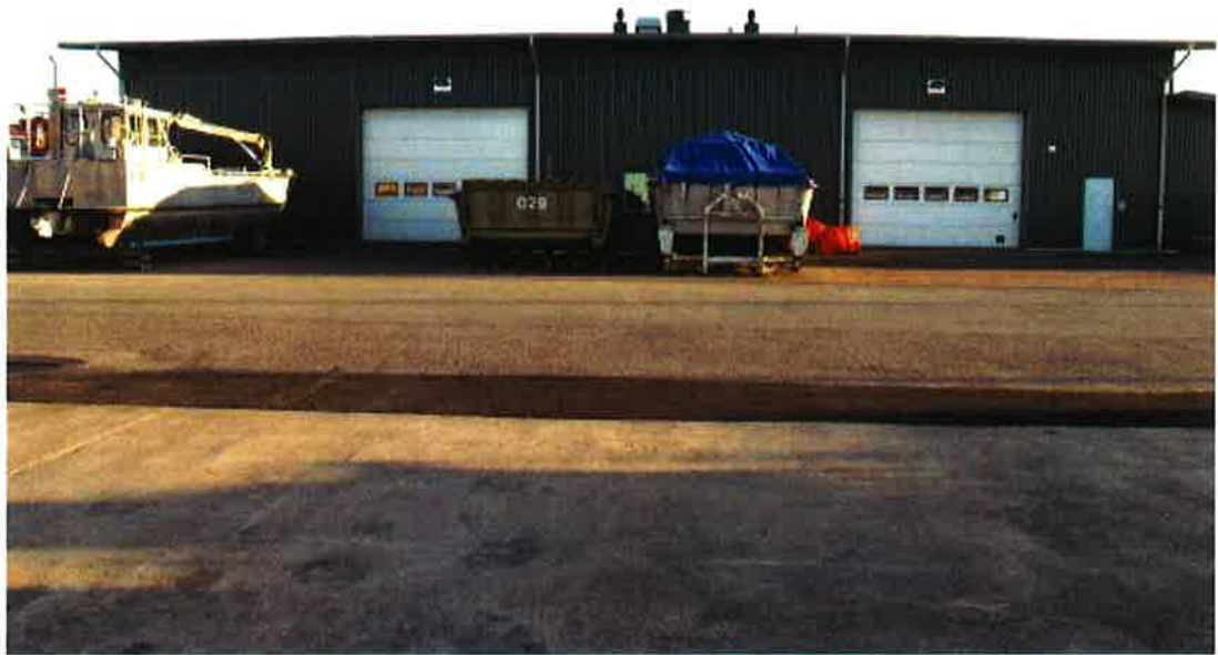
Miljöhallen från norr
